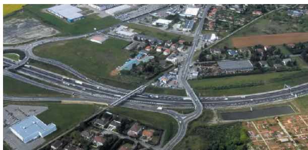
La rocade est (A46) à la limite entre Décines-Charpieu et Meyzieu est traversée par le CFEL. L'échangeur donne accès aux RD 6 et 517, à une zone d'activités et aux quartiers pavillonnaires de Meyzieu.
