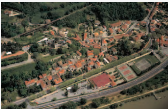
Le centre ancien.
