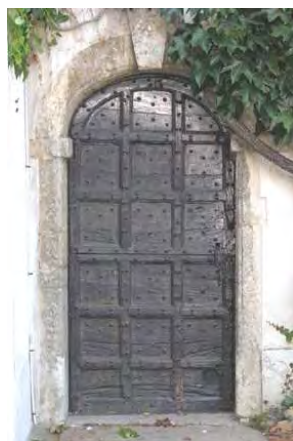
Porte à panneaux cloutés
