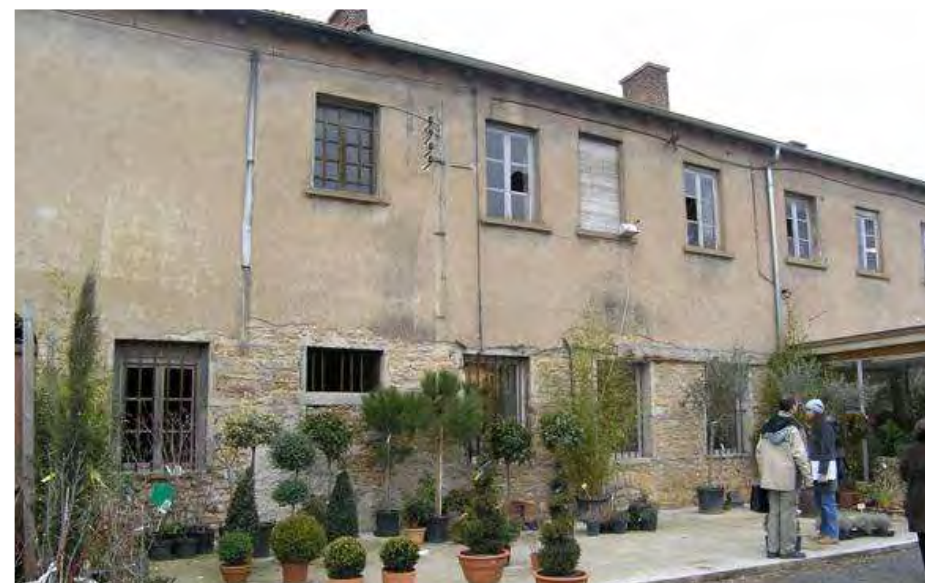
Ancienne manufacture royale : enduit en cours de décollement.
