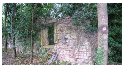
Mur de soutènement (limite Montanay).
