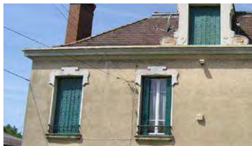
Corniche ciment (villa avenue Van Doren).
