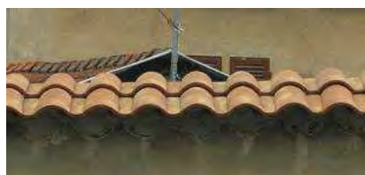
Couvertine en tuiles canal.
