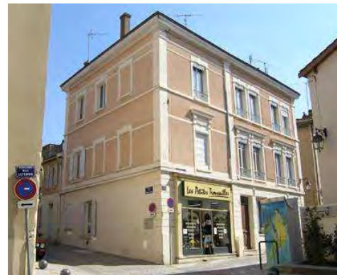
Maison (rue de Biron), enduite.
