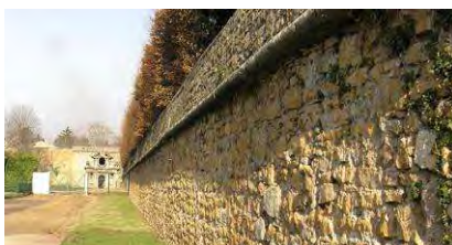
Mur de soutènement (jardin d'Ombreval).
