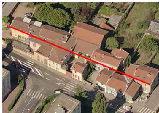
Alignement de « second rang » au niveau du carrefour
